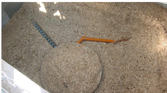
Slika Pogreška! U dokumentu nema teksta navedenog stila..6227 Sustav pražnjenja s zglobnom rukom (stezaljkom) za kvalitetnu drvenu sječku i pelete (izvor: Holz-energie Schweiz).
