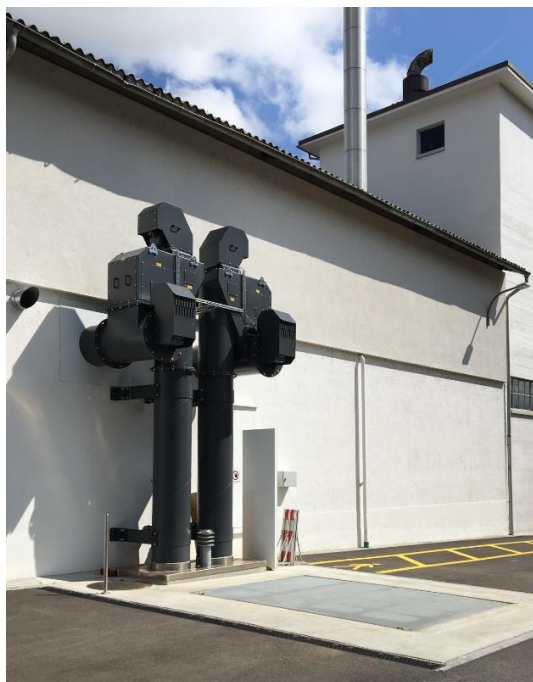
Slika Pogreška! U dokumentu nema teksta navedenog stila..4813 Vertikalni vijčani transportni sustav (izvor: Schmid energetska rješenja).
