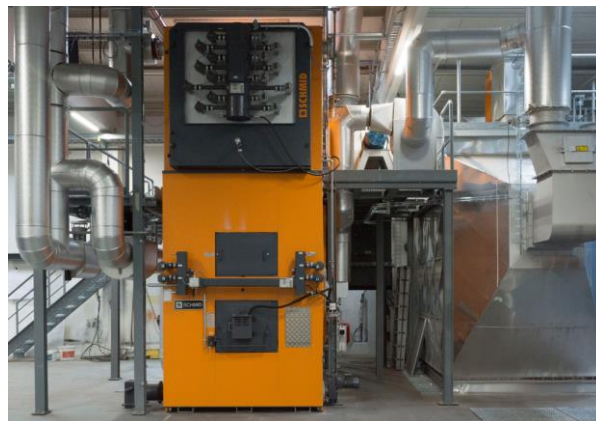
Slika Pogreška! U dokumentu nema teksta navedenog stila..2311 Automatsko čišćenje cijevi kotla (Izvor: Schmid energetska rješenja).
