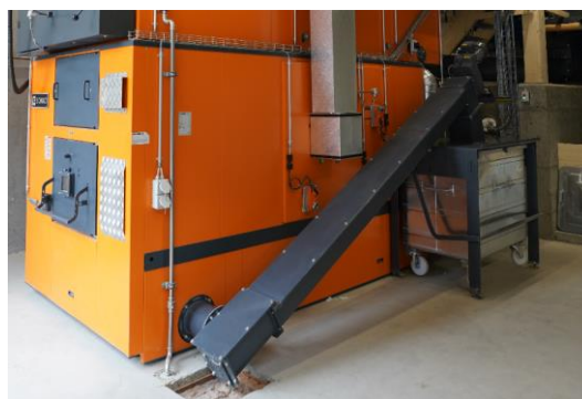
Slika Pogreška! U dokumentu nema teksta navedenog stila..7439 Vijak za pepeo od požara (izvor: Schmid AG energetska rješenja).
