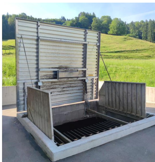
Slika Pogreška! U dokumentu nema teksta navedenog stila..438 Silo poklopac nije dostupan kada je otvoren (izvor: Schmid energetska rješenja).
