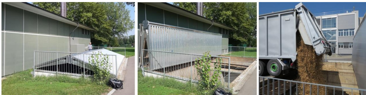
Slika Pogreška! U dokumentu nema teksta navedenog stila..45 Ne pristupačni sklopivi poklopac (lijevo zatvoren, sredinom otvoren, desno punjenje. Izvor: Patrik Küttel).
