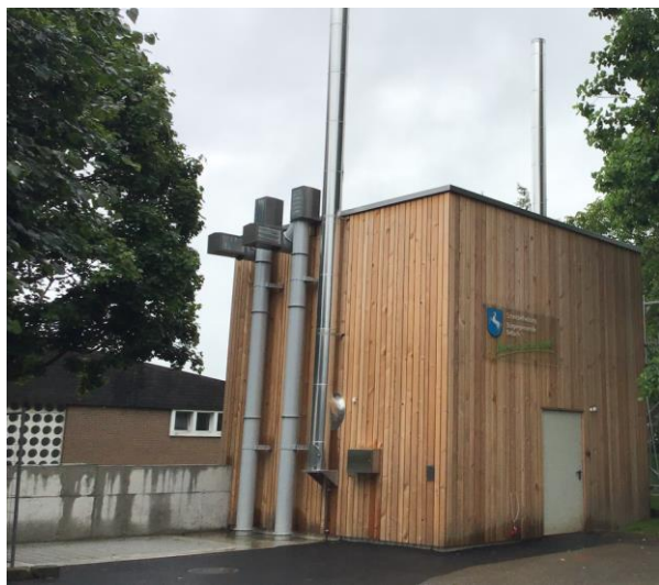
Slika Pogreška! U dokumentu nema teksta navedenog stila.. 14832 Centralna toplana kao montažni element s integriranim ili dodatnim spremnicima goriva (izvor: Holzenergie Schweiz).
