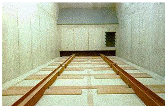
Slika Pogreška! U dokumentu nema teksta navedenog stila.. 5621 Pražnjenje silosa pomoću potisnog poda (izvor: Schmid energetska rješenja).
