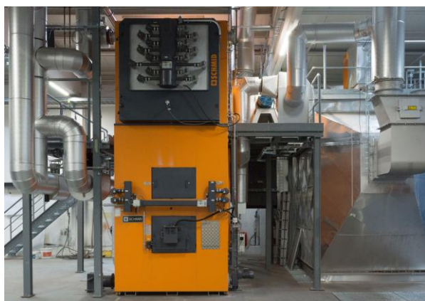
Wykres Errore. Nel documento non esiste testo dello stile specificato..23 Automatyczne czyszczenie rur kotła (źródło: Schmid energy solutions).
